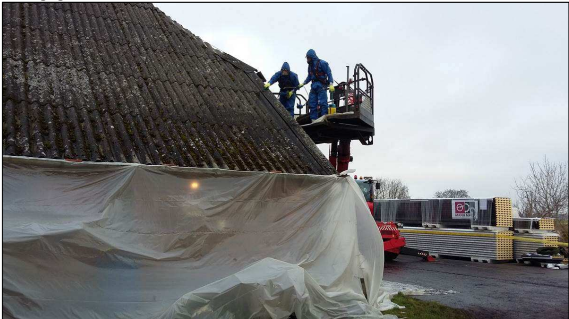
Afbeelding 2.1 Vervanging van een asbestdak in Drenthe
